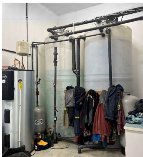
Figure 9. Réservoir d'eau potable (gauche) et réservoir d'eaux récupérées (droite) à la Ferme Gilbert et Fils inc. (source : Agrinova)
