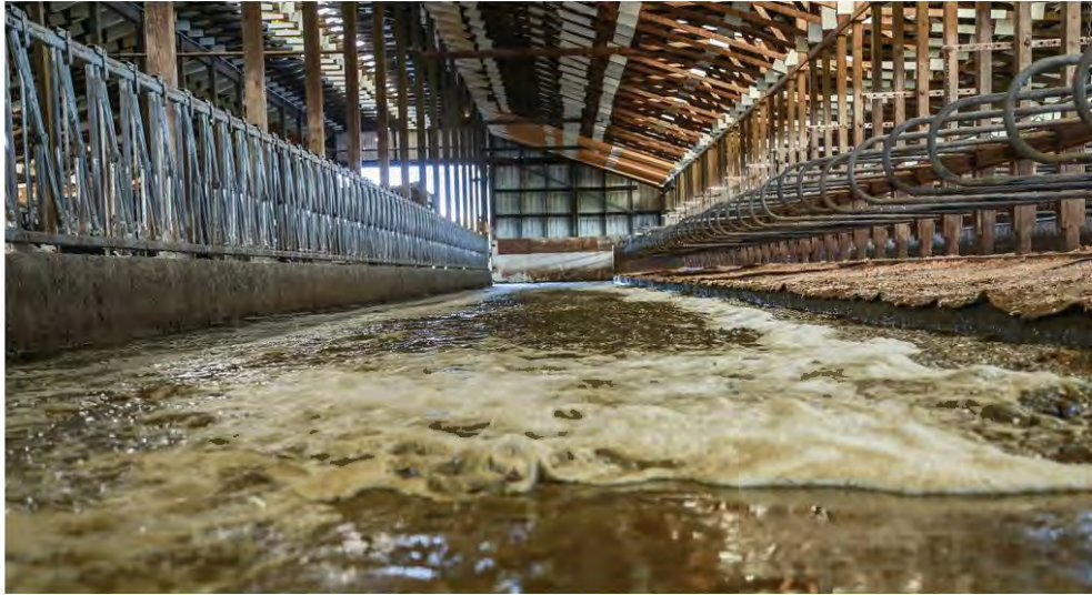
Figure 6. Lavage des allées grâce à un système de chasse d'eau (source : Darigold)
