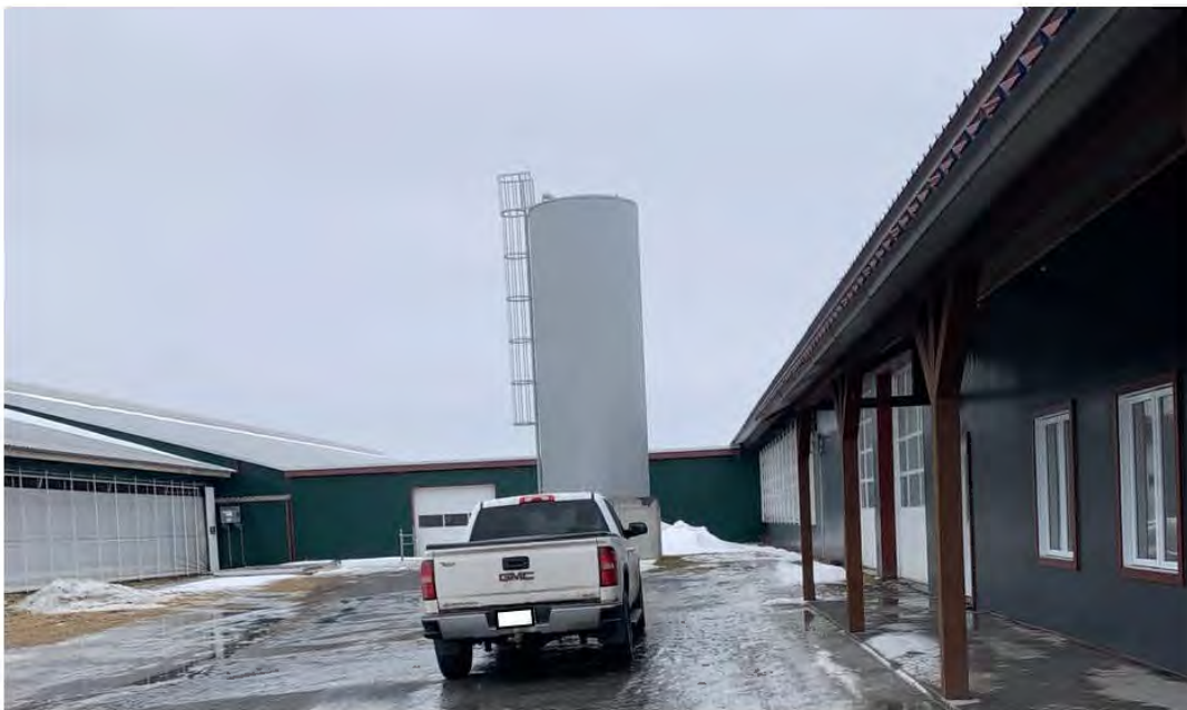
Figure 20. Tour munie d'un système de décantation servant également de réservoir de stockage de l'eau récupérée à la Ferme Irma (source : Agrinova)
